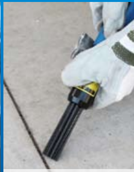
コンクリートの目荒らし
