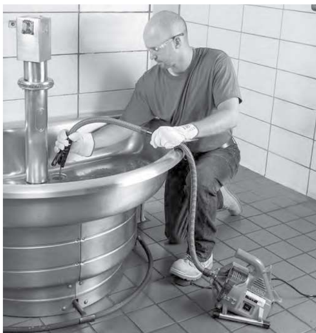
図 11 – ケーブルの回収
