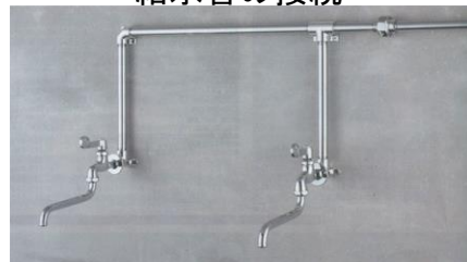
給水管の接続
