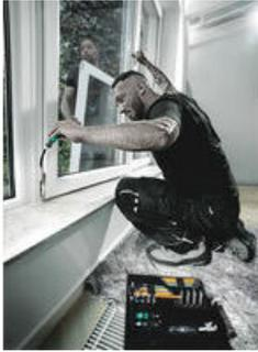
コーナー部分のねじ回しに最適な393 Sドライバー。柔軟性のあるシャフトにより、作業し辛い位置の固定ネジにも手が届くようになっています。手が届きにくい状況でのねじまわしに最適なツールです。
