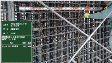
鉄筋の撮影に
