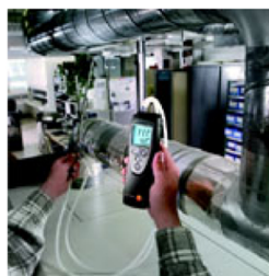
ピトー管を接続して作業現場の風速チェック
