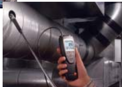
ダクト内の風速計測
