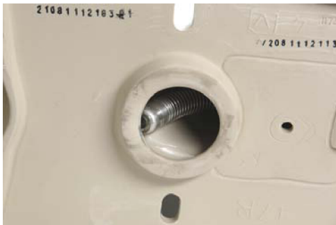
図 21：カメラヘッドが曲がり目で詰まっています
