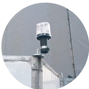
ゲート上部設置
