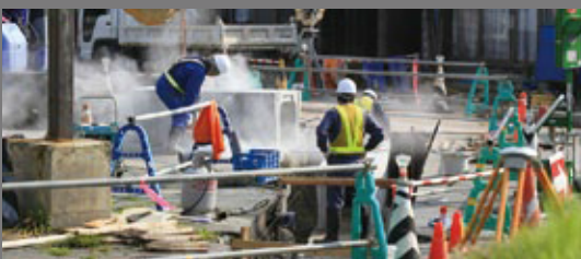
土木・工事現場
