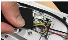
電源用以外の配線を収納した写真
