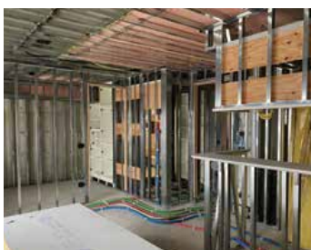
通電前の屋内作業に
