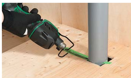
塩ビ管の切断
