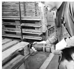
パレットの解体作業に！
