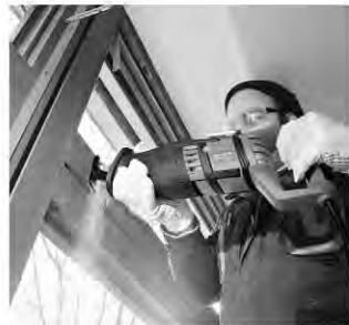
取り壊し作業に！
