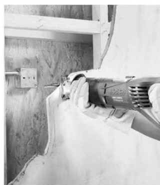
■取り壊し作業に。
