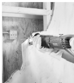
■取り壊し作業に
