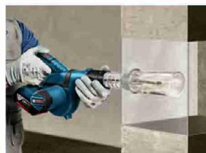
アンカーノズルと防じんカップにより、ケミカルアンカーの下穴清掃作業が簡単に行えます。
