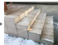
散布後2時間50分経過 凍結面に散布し、シャーベット化。滑りにくくなります。
