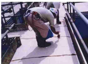
床面施工の様子
