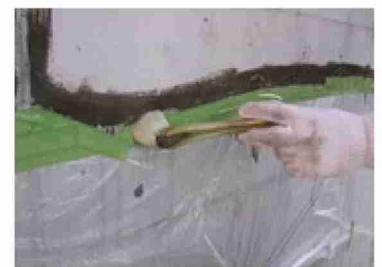
壁面施工の様子
