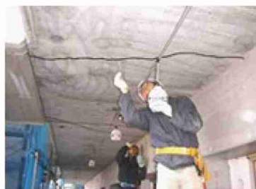
天井面施工の様子
