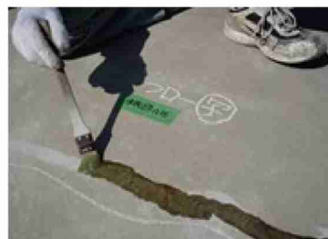
床面施工の様子
