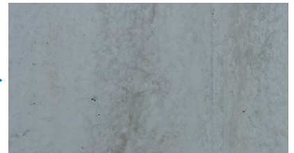
クラック補修完了
