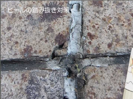
コンクリート床のひび割れ補強接着
