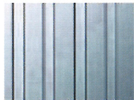
ガルバリウム鋼板のサイディング
