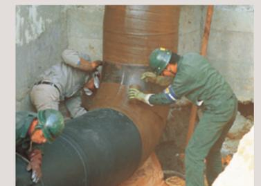
●冷却水用埋設鋼管の防食
