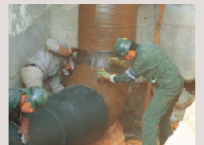
●冷却水用埋設鋼管の防食
