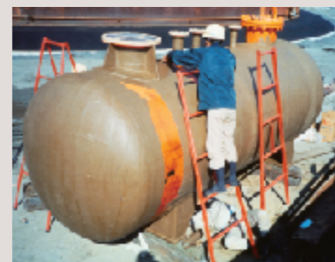
●埋設タンクの外面防食
