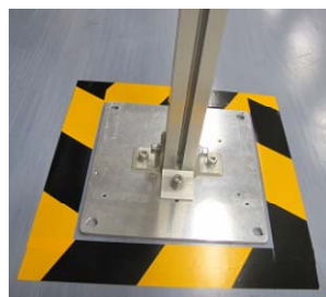
異型柱の周りに
