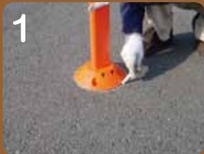
1 ベースの周りをチェーンで囲み設置位置を決めます。※ポストの向きを道路と平行に設置して下さい。
