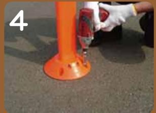
4 穴の位置を確認しアンカーを締め込み完成です。
