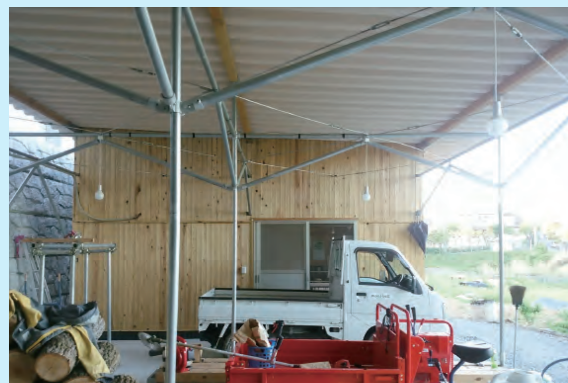
作業場構造体
