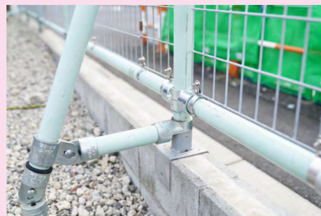
屋外フェンス
