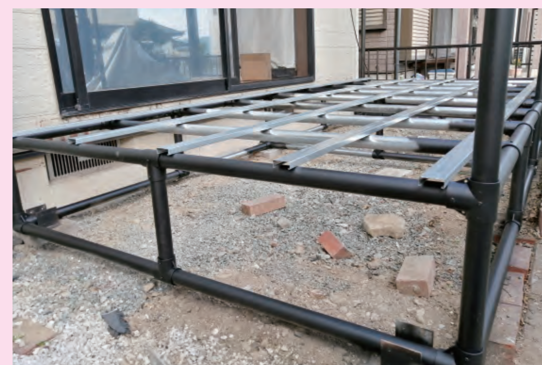
ウッドデッキ骨組
