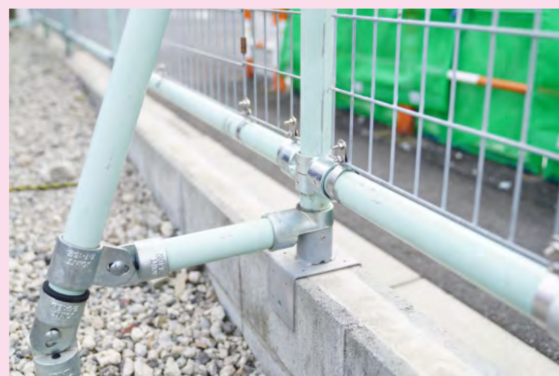
屋外フェンス
