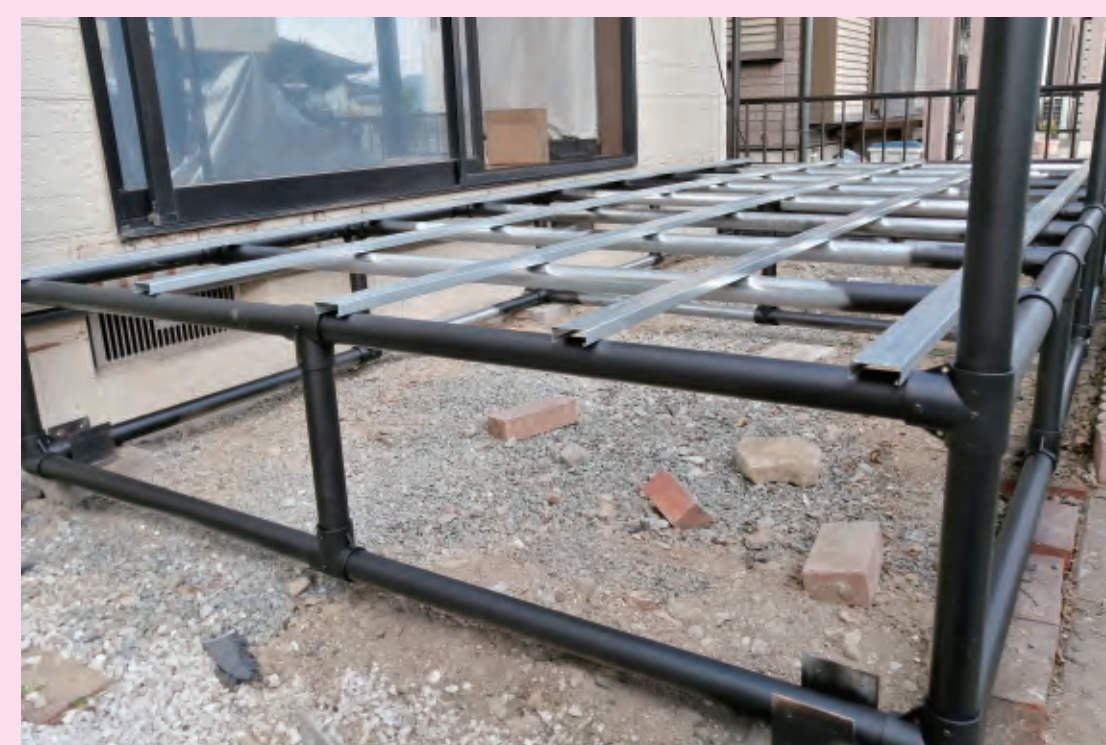
ウッドデッキ骨組
