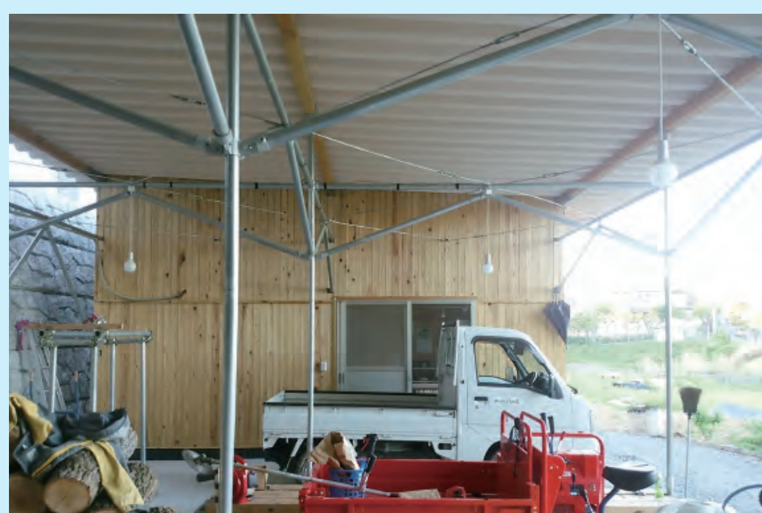
作業場構造体
