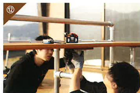
⑫ カウンタートップを水平に固定
