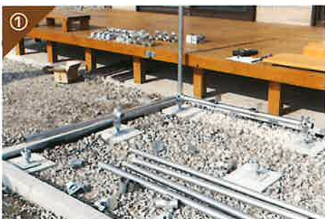
① 基礎フレームを組み上げ
