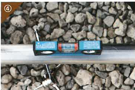
④ 水平調整金具で水平出し
