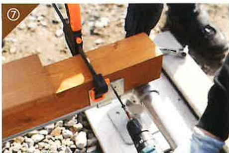
⑦ 大引を木材留め金具に固定
