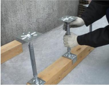
大引の両端の鋼製束は設計高さに合せ、内部側の鋼製束はそれより少し低い目にしておきます。
