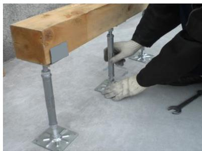
内部側の鋼製束のパイプを回して高さを合せ、⑪と同様に、ベース面を床面に接地させ、接着する。
