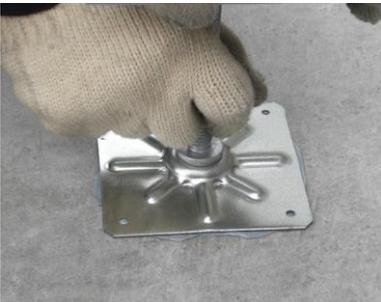
大引の両端の鋼製束のベース面を床面にしっかり接地させ、接着剤が外周部から少しハミ出すくらいに広めになじむ様に押し付けて下さい。
