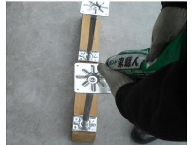
全ての鋼製束のベース裏面にボンド「束職人」を約20g塗布します。
