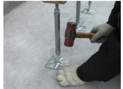
接着剤による浮き上がり防止・養生までの固定補助の為、コンクリート釘を任意の対角に2本打ちます。
