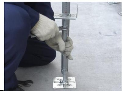
鋼製束と大引をネジ止めしていく前に、大引の両端に取付ける鋼製束の高さを、設計束高さに合わせておきます。
