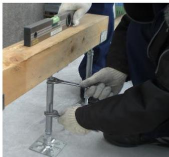
レベル確認が完了し、鋼製束の高さが決まれば、上下の六角ナットを本締めします。
