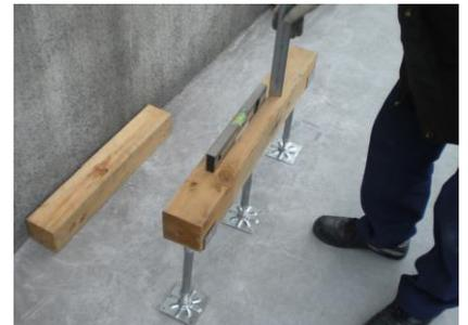
最終のレベル確認を行います。鋼製束の本締めが全て出来ている事も確認して置いて下さい。
