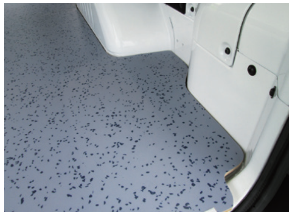
車体の凸凹に合わせて床板をカットします。
