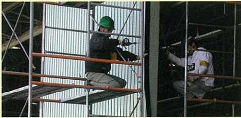
高さ約6mのハンガードアも二名で約30分から40分で取付けを完了します。
