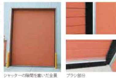
シャッターの隙間を塞いだ全景 ブラシ部分
