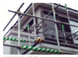
建築現場の足場
