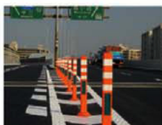
阪神高速道路 守口ランプ
