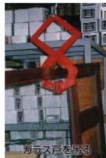
ガラス戸を吊る
