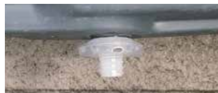
エアコン室外機の底面にアジャスターを取り付け
