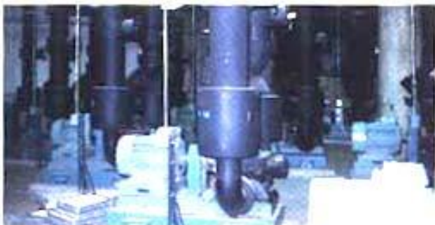
熱伝導率・吸湿率・吸水率の低さは、冷水配管用に最適です。
