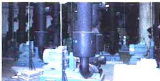
熱伝導率・吸湿率・吸水率の低さは、冷水配管用に最適です。
