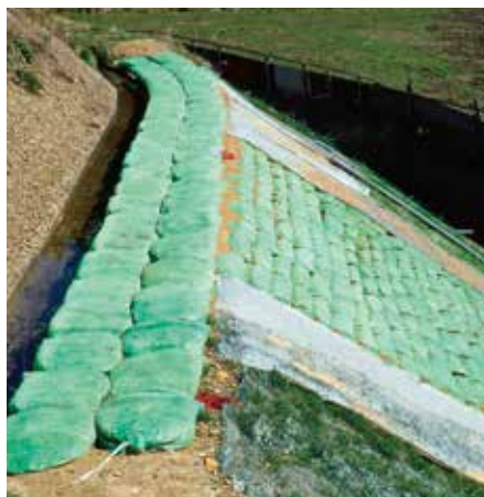
法面崩壊部分の埋戻し
