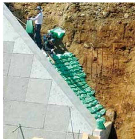
擁壁裏の土砂流出防止
