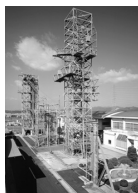
屋外試験鉄塔群
