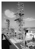
屋外試験鉄塔群
