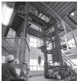
屋内試験鉄塔
