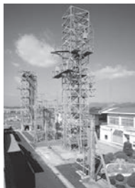
屋外試験鉄塔群
