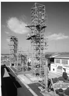
屋外試験鉄塔群
