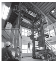
屋内試験鉄塔
