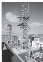
屋外試験鉄塔群
