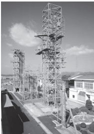
屋外試験鉄塔群
