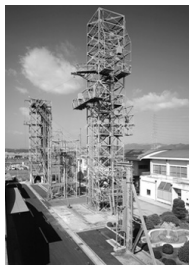
屋外試験鉄塔群
