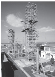
屋外試験鉄塔群
