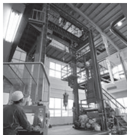
屋内試験鉄塔
