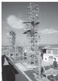
屋外試験鉄塔群
