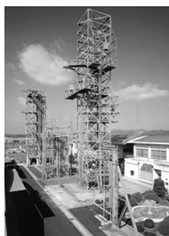
屋外試験鉄塔群
